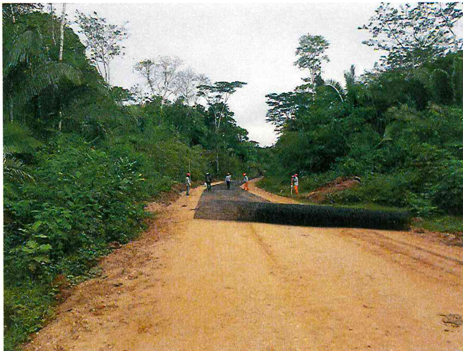
FOTO N°08: COLOCACION DE GEOMALLAS, PARA SUB BASE
