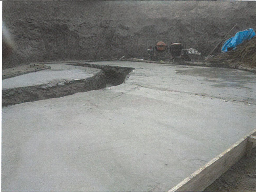
FOTO N°07: VACIADO DE CONCRETO, PARA SOLADO DE ESTRIBOS EN EL PUENTE LOBOICO.
