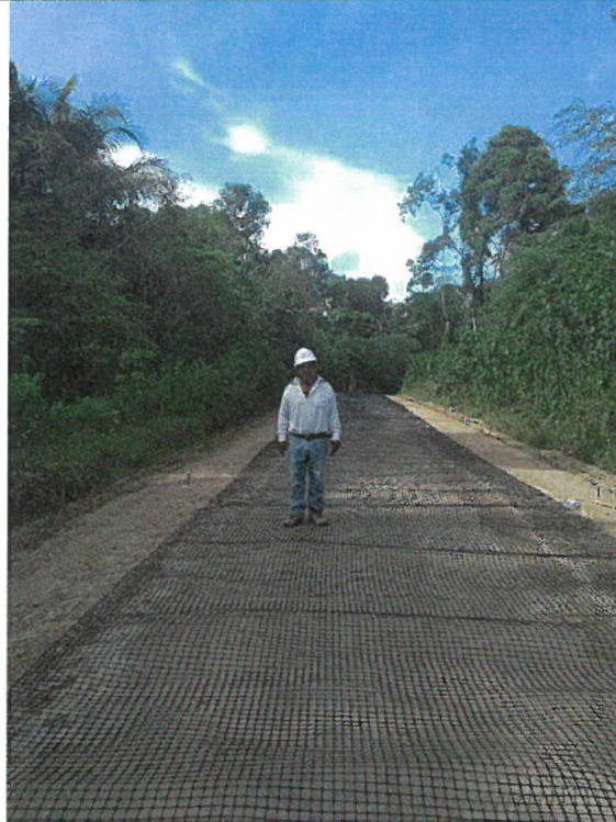
FOTO N°05: COLOCACIONES DE LAS GEOMALLAS BIAXIALES, PARA REALIZACIÓN DE BASE.
