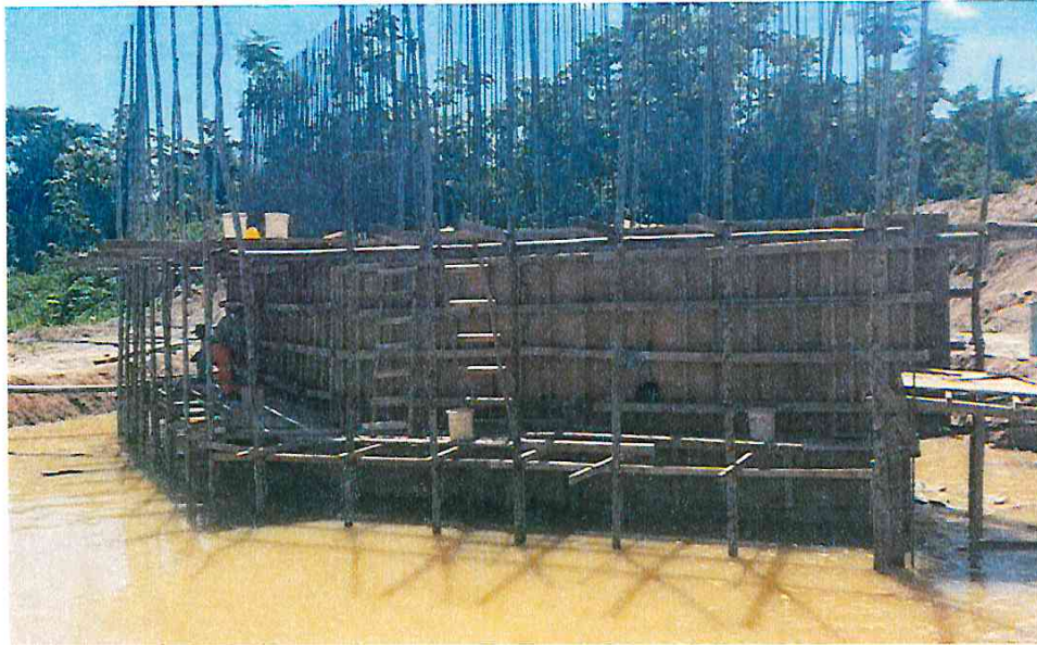
FOTO N°07: REALIZACION DE ENCOFRADO PARA PANTALLA DEL PUENTE CACHIYACU
