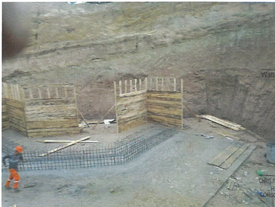
FOTO N°06: ENCOFRADO PARA ESTRIBOS DEL PUENTE LOBOICO.
