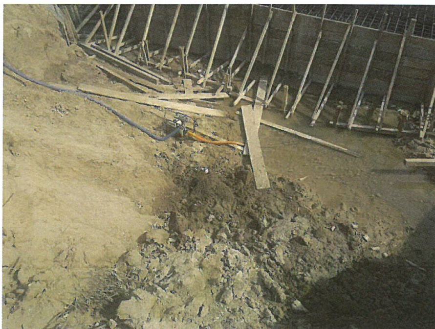
FOTO N°04: BOMBEO CONTINUO EN AMBOS ESTRIBOS DEL PUENTE CACHIYACU
