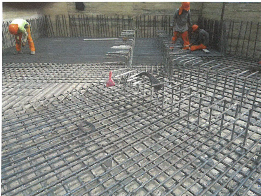
FOTO N°03: ARMADO DE ESTRUCTURA DE CIMENTACION DEL ESTRIBO DERECHO DEL PUENTE LOBOICO - ADICIONAL 04
