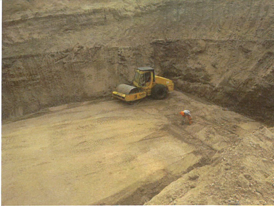
FOTO N°09: RELLENO Y COMPACTACION PARA CIMENTACIONES DE ESTRIBOS DEL PUENTE LOBOICO.
