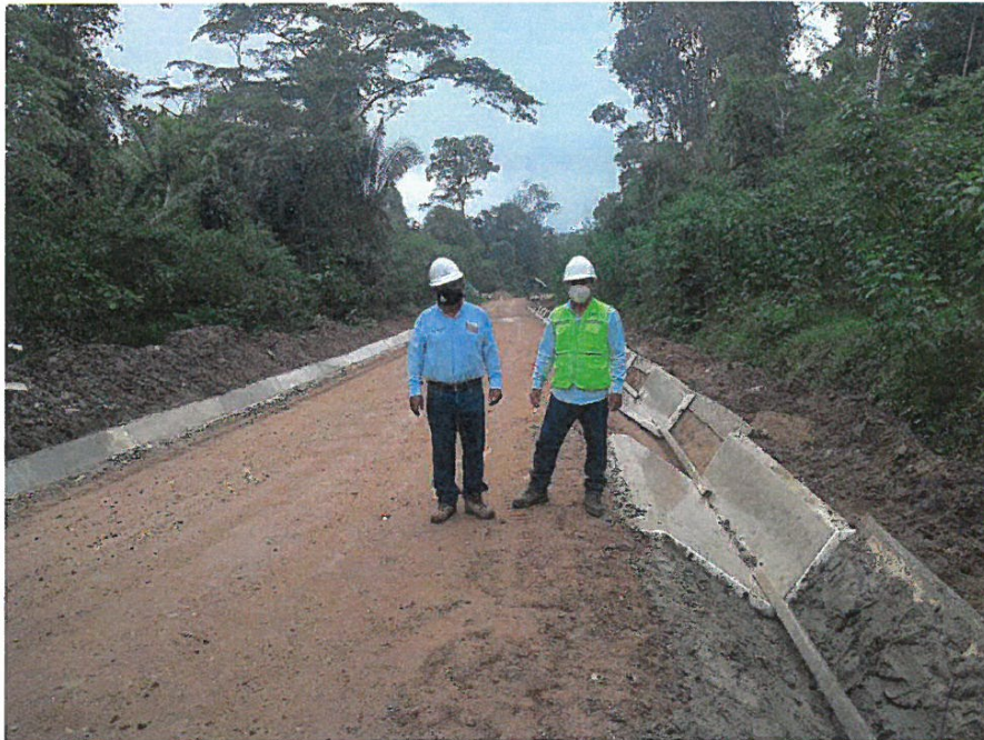
FOTO N°10: REALIZACION DE CUNETAS
