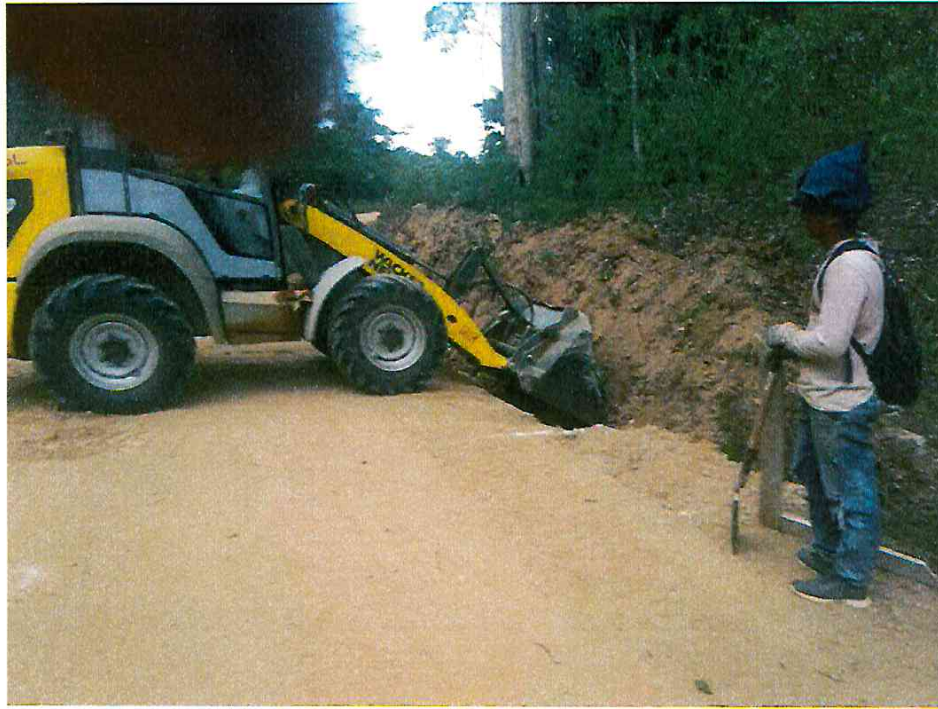
FOTO N°01: CONFORMACION DE CUNETAS
