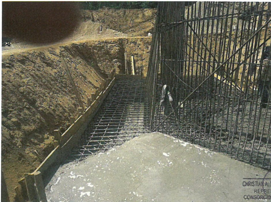
FOTO N°02: VACIADO DE CONCRETO F'C= 245 KG/CM2 EN ESTRIBO DERECHO DEL PUENTE CACHIYACU - ADICIONAL 03
