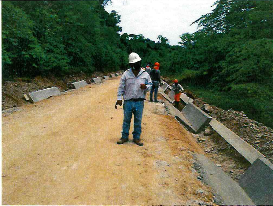
FOTO N°03: SUPERVISION EN LA REALIZACIÓN DE CUNETAS.
