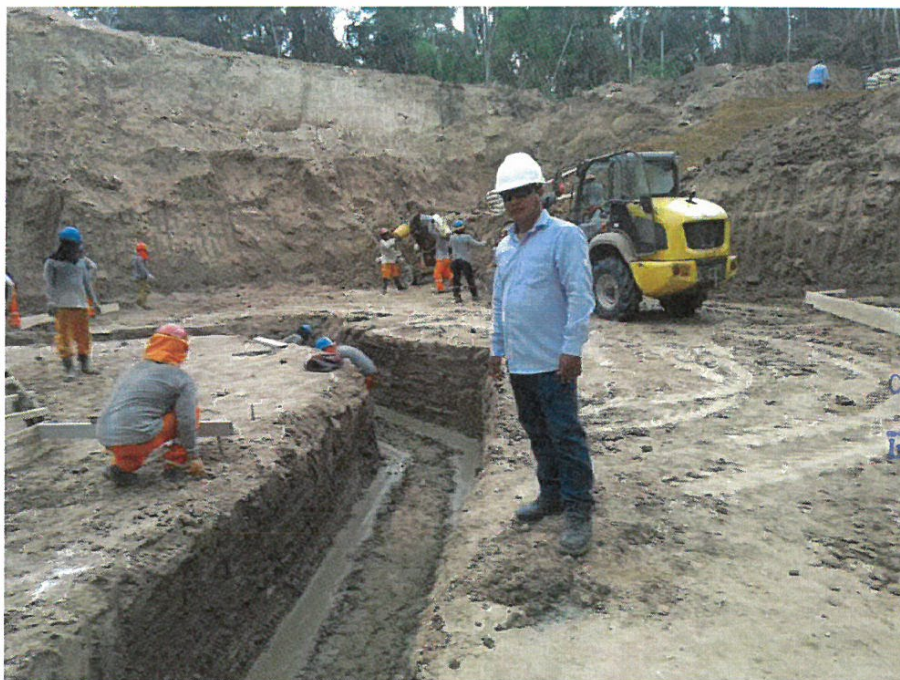
FOTO N°08: REALIZACIÓN DE SOLADO, PARA UÑAS DE ESTRIBOS EN EL PUENTE LOBOICO.
